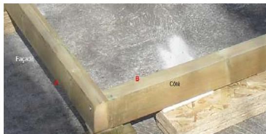
Il faut systématiquement **commencer le montage par un angle** (côté opposé à la porte, arrière de l'abri). Les panneaux de côtés viennent se fixer entre les panneaux de façades et arrières de l'abri. Dans un premier temps, ne pas fixer la structure à la dalle ou au plancher. Vérifier les parallèles de la porte en position haute et basse du cadre de la porte, et s'il y a lieu, réajuster les panneaux entre eux avant de fixer les panneaux au plancher ou à la dalle.
