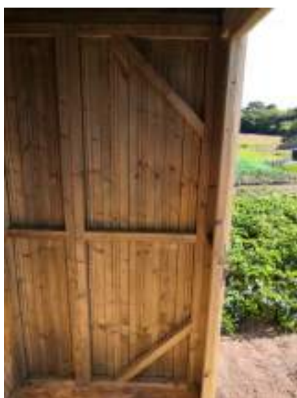
Contreventements de nos panneaux pour une meilleure stabilité
