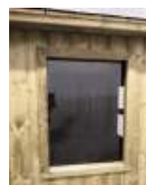
Châssis fixe (dormant avec pare-close)
