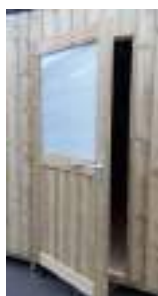
Vitrage plexiglass opaque sur battant d'une porte de 0.875 m
