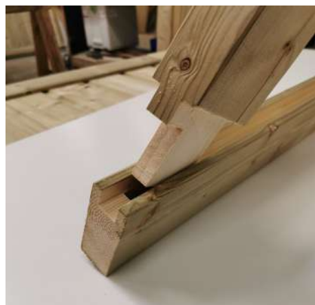
Assemblage traditionnel de nos portes par tenon et mortaise
