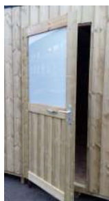
Vitrage plexiglass opaque sur battant d'une porte de 0.875 m
