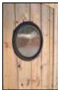
Hublot diamètre 31 uniquement sur les portes 0.875m - 1.23m - 1.75m
